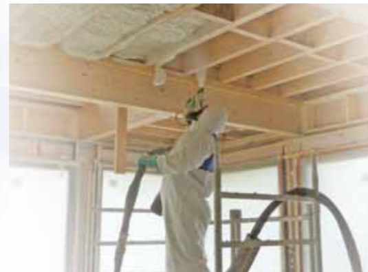
Polyurethane foam spray-up units Projection de mousse polyuréthane
